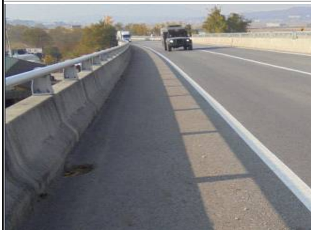
난간 및 연석 전경
